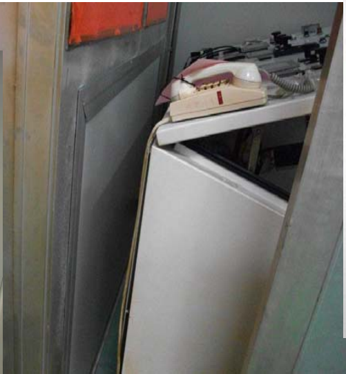
改善前:後方無作業開口
